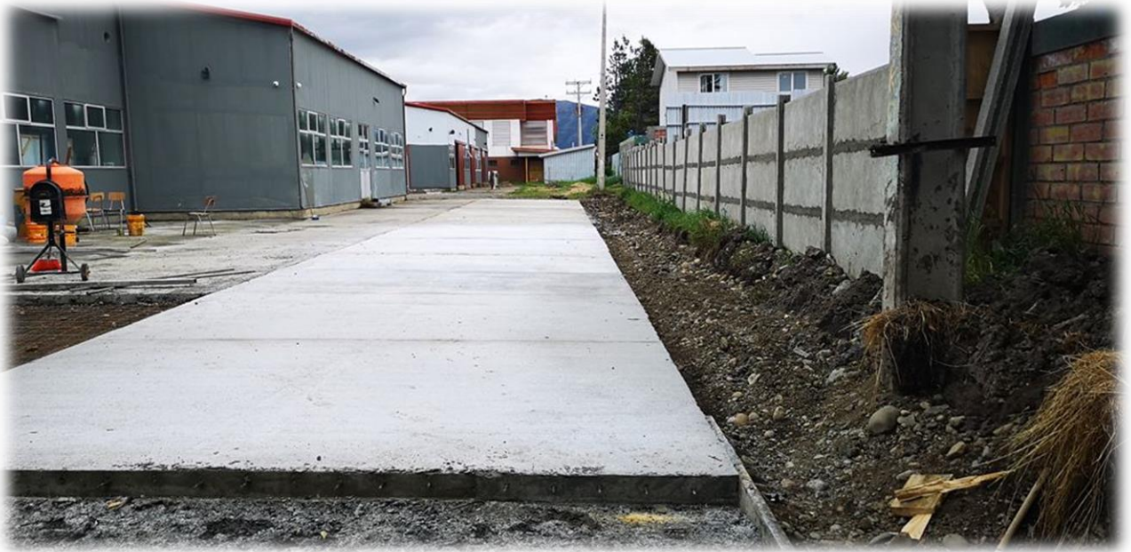
Fuente: Fotografía Departamento Planificación Cormunat (Proyecto Mejoramiento Patio Acceso LCM)
